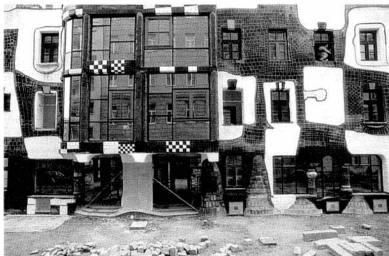
Fassade im Bau
