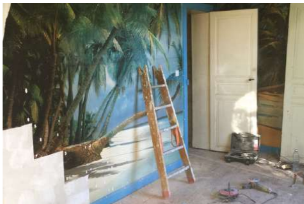
Le Second jeudi : site en construction. CRÉDIT : Aude Noguès
