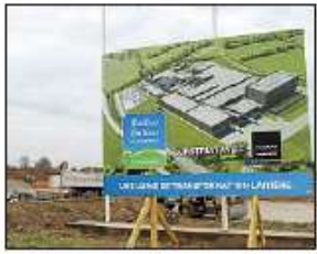
Le chantier de la future usine des Maîtres Laitiers de Cochenin à Méautis, près de Caen, débute. Un investissement de 14 millions de euros pour 200 emplois.
