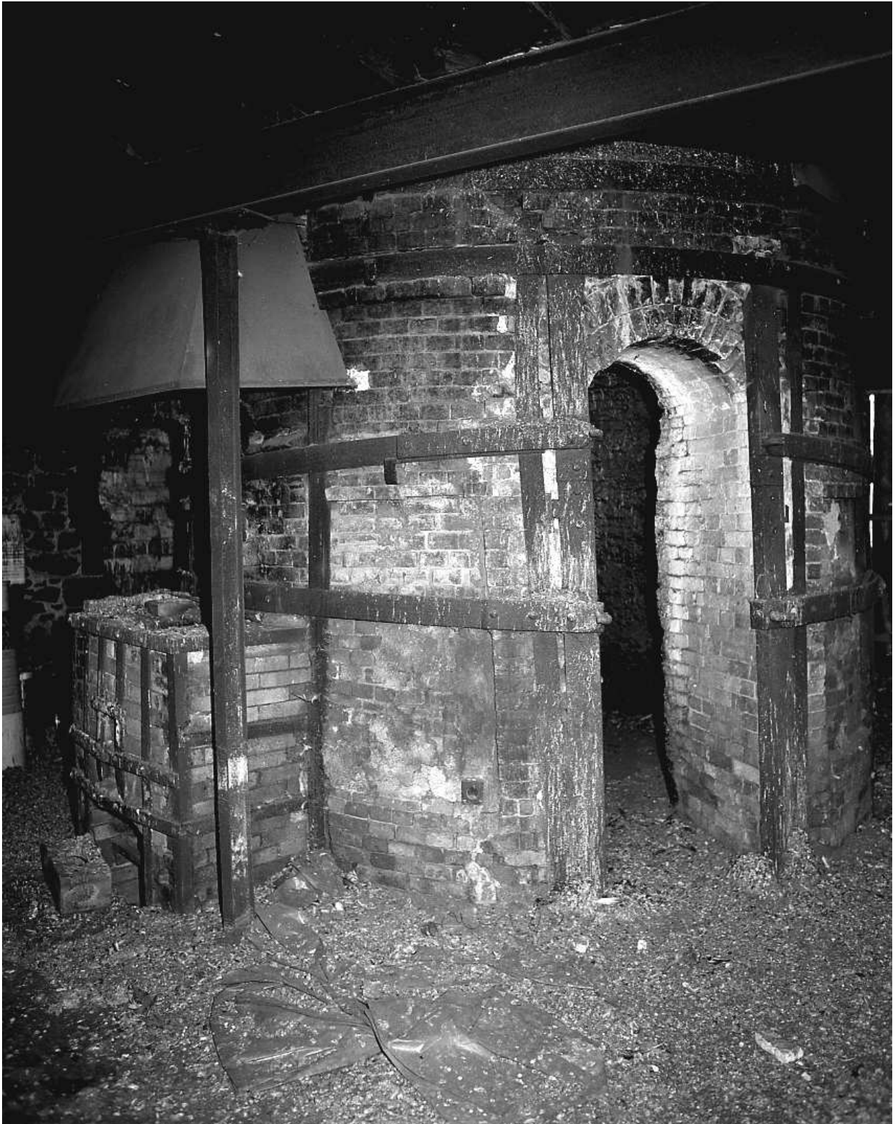
Fig.3 Four à globe : l'orifice du laboratoire (premier niveau du four) et l'un des deux alandiers.
