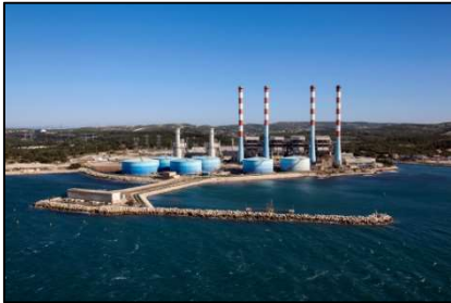
Centrale thermique à gaz de Martigues (Bouches du Rhône)
