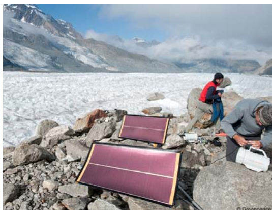
2 : Vue générale du chantier
