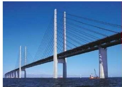
Les ponts à haubans ne tiennent pas comme les ponts suspendus, grâce à deux câbles principaux ancrés sur les rives, mais grâce à de nombreux câbles obliques (haubans) attachés d'un coté aux piliers du pont et de l'autre coté au tablier.
